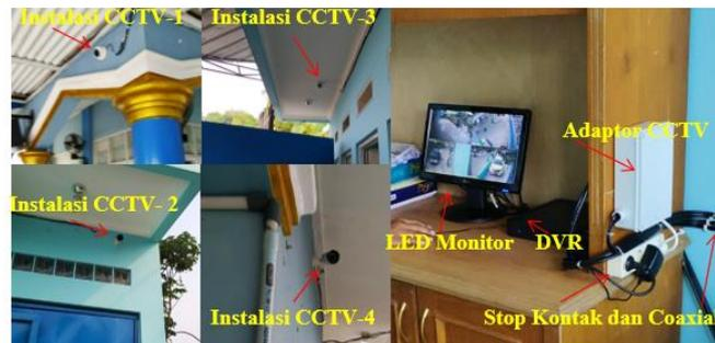
Gambar 2. Instalasi Sistem CCTV
