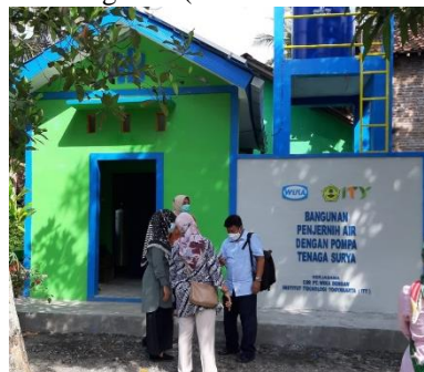
Gambar 5 Bangunan Penjernih Air (Sumber : Dokumentasi Peneliti, 2021)
