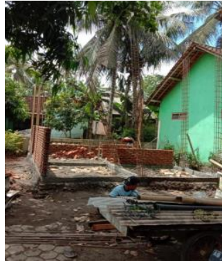
Gambar 4 Proses Pembangunan (Sumber : Dokumentasi Peneliti, 2021)
